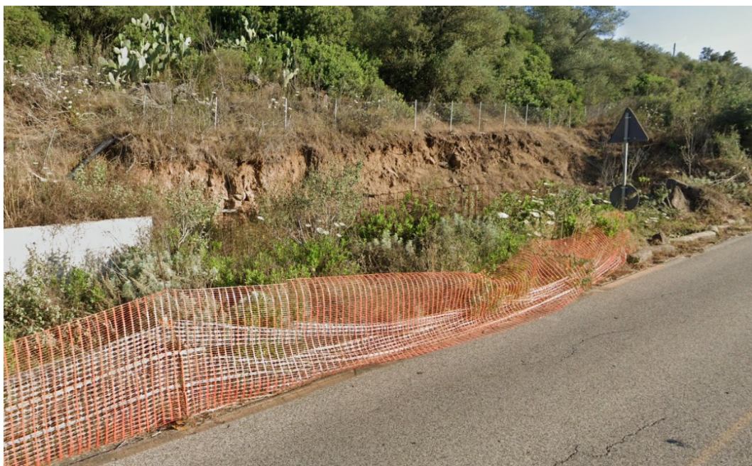
Foto 11: TRATTO A MONTE Muro di controripa, termine del muro già realizzato nel TRATTO INTERMEDIO e zona di raccordo con tratto esistente SP 44 (dal km 0+299,70 m al km 0+330 m)
