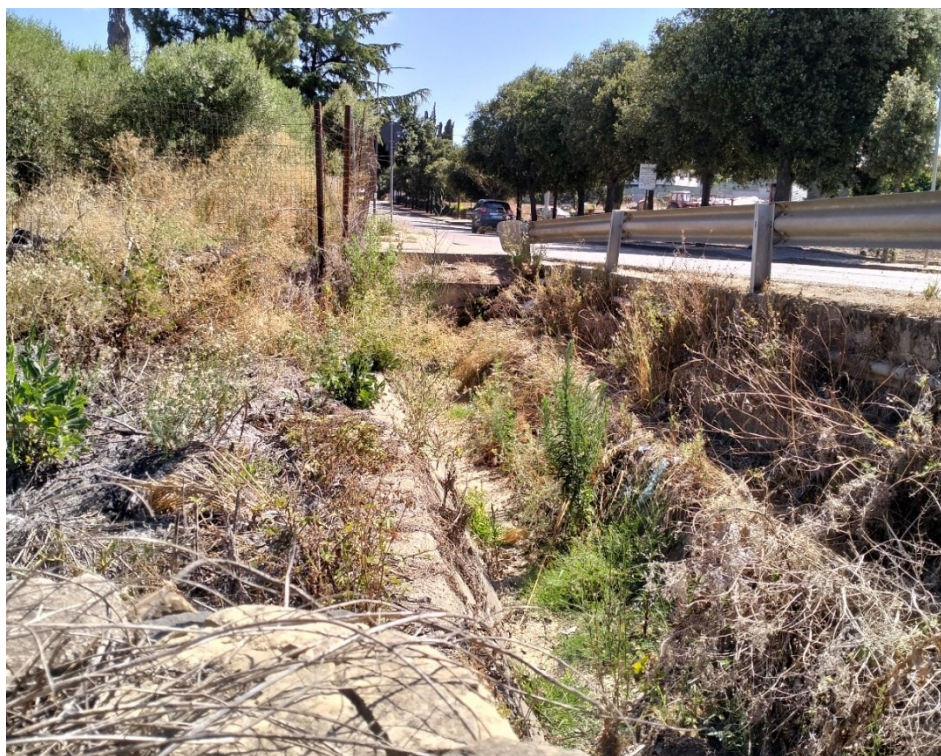
Foto 1: Sbarco iniziale passerella pedonale al km 3+193 m all'ingresso del centro abitato con vista canale in calcestruzzo.
