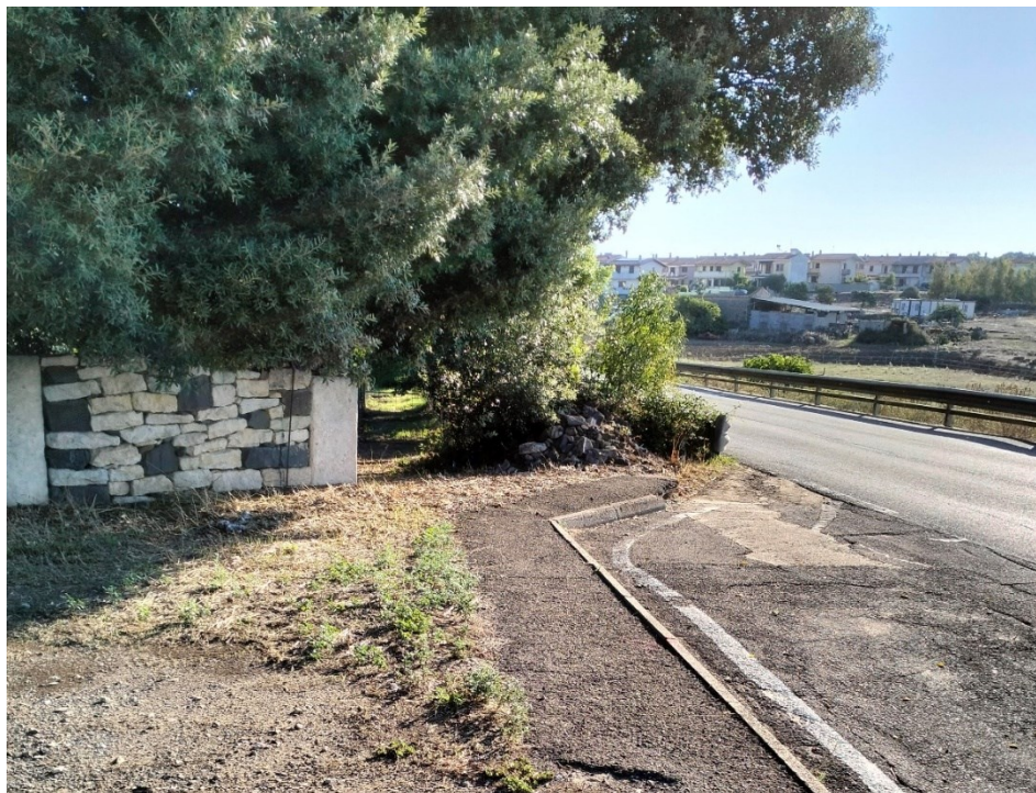
Foto 6: Marciapiede di raccordo zona P.I.P. al km 3+093 m
