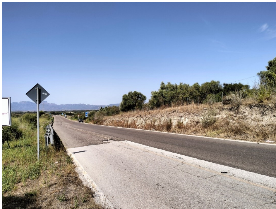
Foto 7: TRATTO DI VALLE Muro di controripa da ultimare (dal km 0+000 m al km 0+093,45 m)
