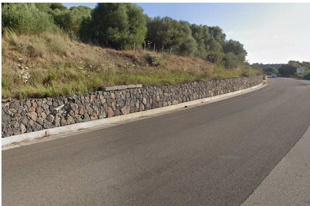
Foto 9: TRATTO INTERMEDIO Muro di controripa già realizzato NON OGGETTO DI INTERVENTO (dal km 0+093,45 m al km 0+299,70 m)
