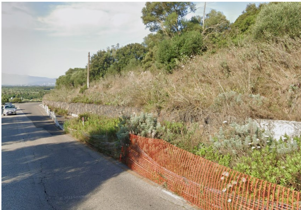
Foto 10: TRATTO INTERMEDIO Muro di controripa NON OGGETTO DI INTERVENTO eccetto sistemazione pavimentazione stradale (dal km 0+093,45 m al km 0+299,70 m)
