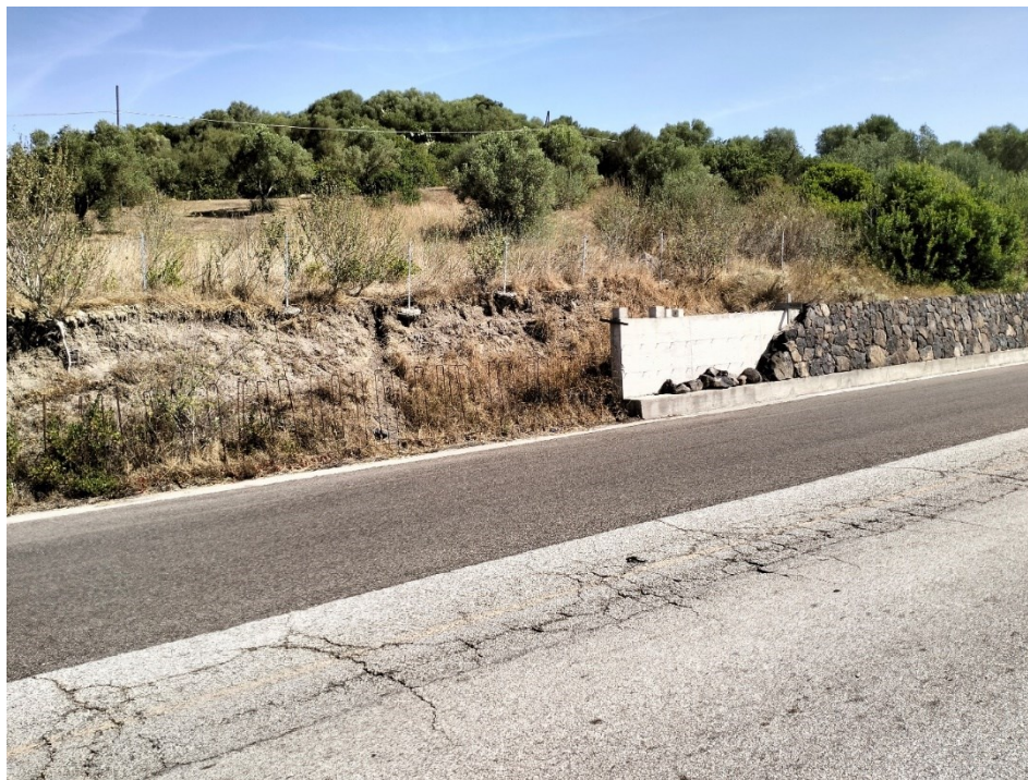
Foto 8: TRATTO DI VALLE Muro di controripa da ultimare in prossimità tratto di muro già realizzato nel "TRATTO INTERMEDIO" (al km 0+093,45 m)
