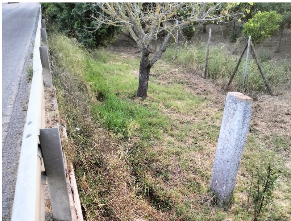
Foto 3: Cunetta in terra zona passerella pedonale (verso zona P.I.P.)
