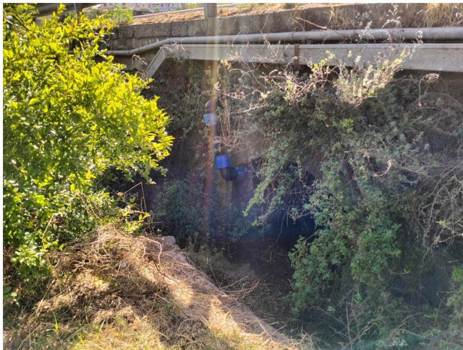
Foto 2: Attraversamento Idraulico SP 44 al km 3+143 m
